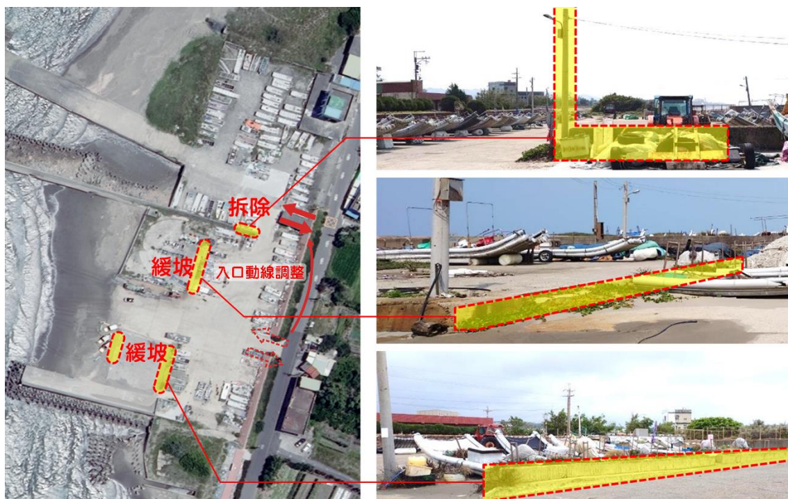
圖 11 白沙屯漁港矮牆現況照
