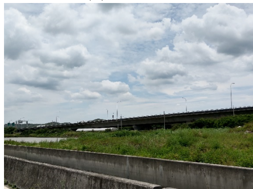
(N) 港區北側空地(養殖區排水東側)
